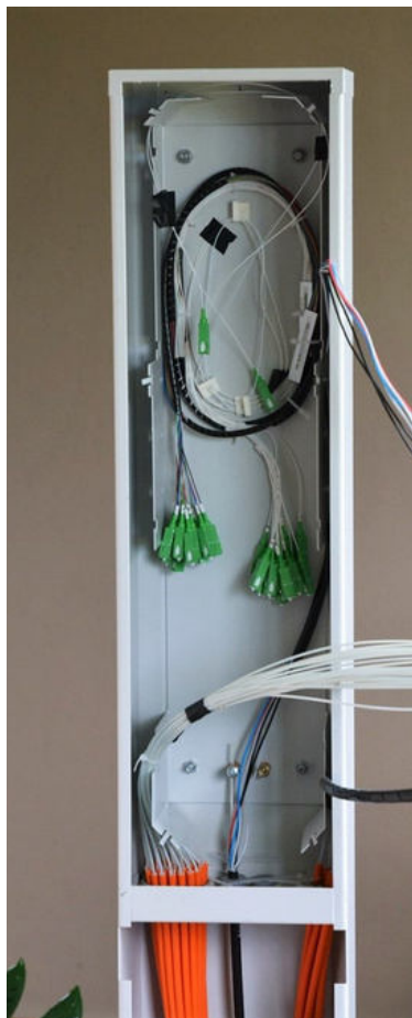
Organizacja zapasu kabli światłowodowych dokoła wkładki wewnętrznej.
