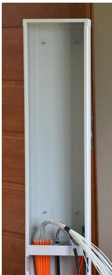
Montaż mikrokabla DAC.
