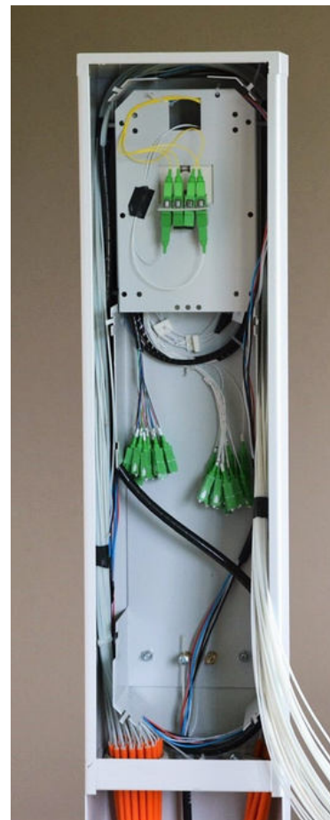
Ułożenie tub oraz pigtaili w dedykowanych przestrzeniach.
